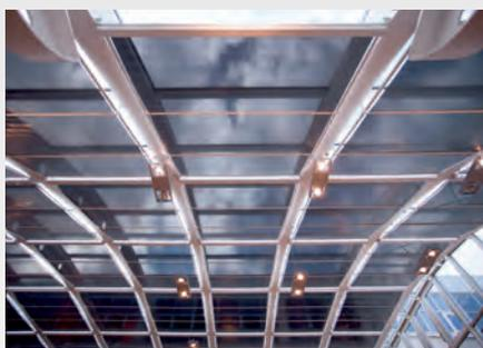
Im Karstadt Warenhaus Stuttgart sorgt ein gläsernes Kuppeldach für lichtdurchflutete Verkaufsräume. Im Zuge einer Sanierung wurde die bisherige Außenverschattung durch innen liegende Sonnenschutzsysteme von MULTIFILM® ersetzt.
